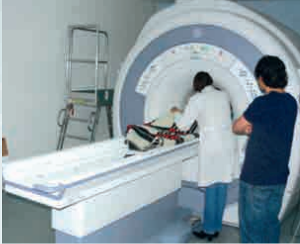
Instalación equipo resonador magnético Instituto de Gastroenterología - Sucre
