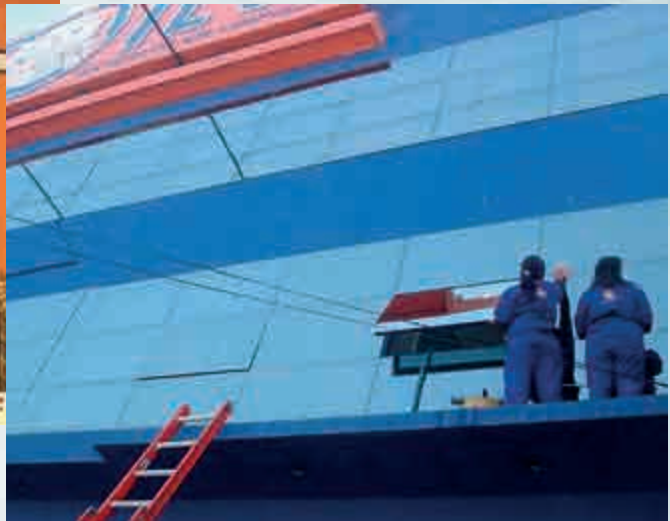
Infraestructura TOTE's La Paz
