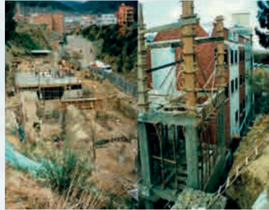
Obras sobre el lecho del río
