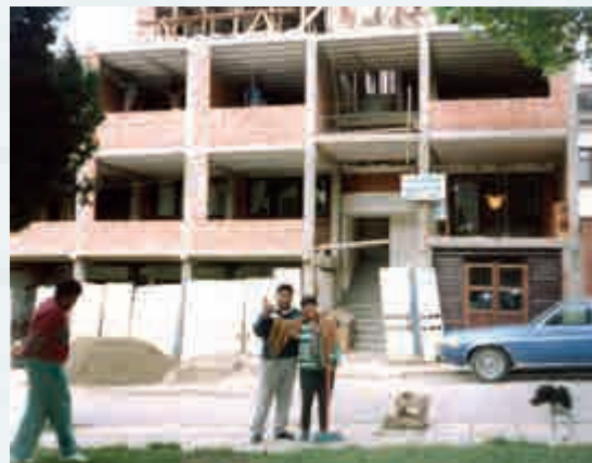
Funeraria Valdivia en construcción La Paz
