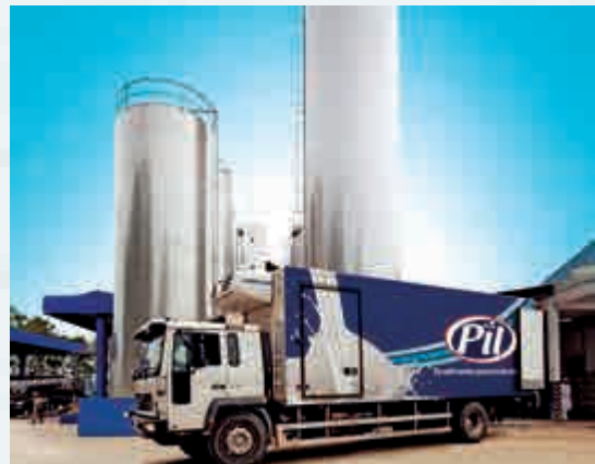
Tanques de recepción de leche cruda
