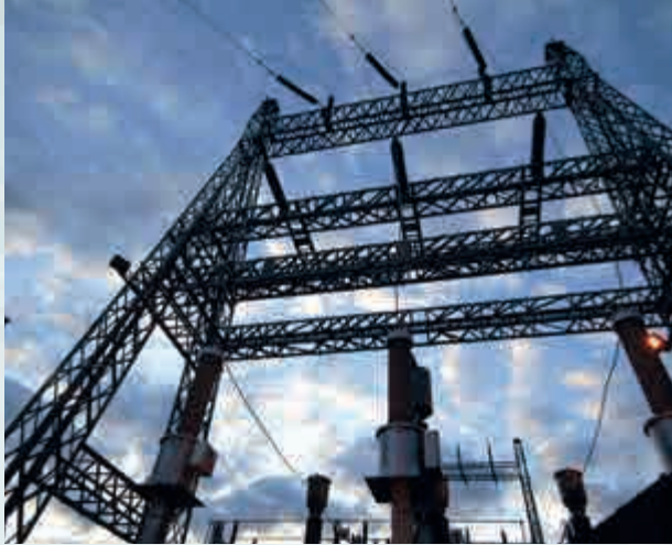
Subestación Pichu, de enlace al Sin
