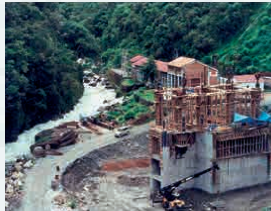
Planta Chojlla Durante la construcción
